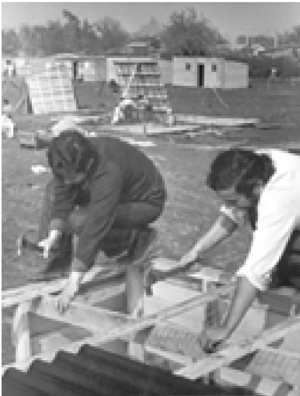
Chile, Trabajos Voluntarios, 1972
