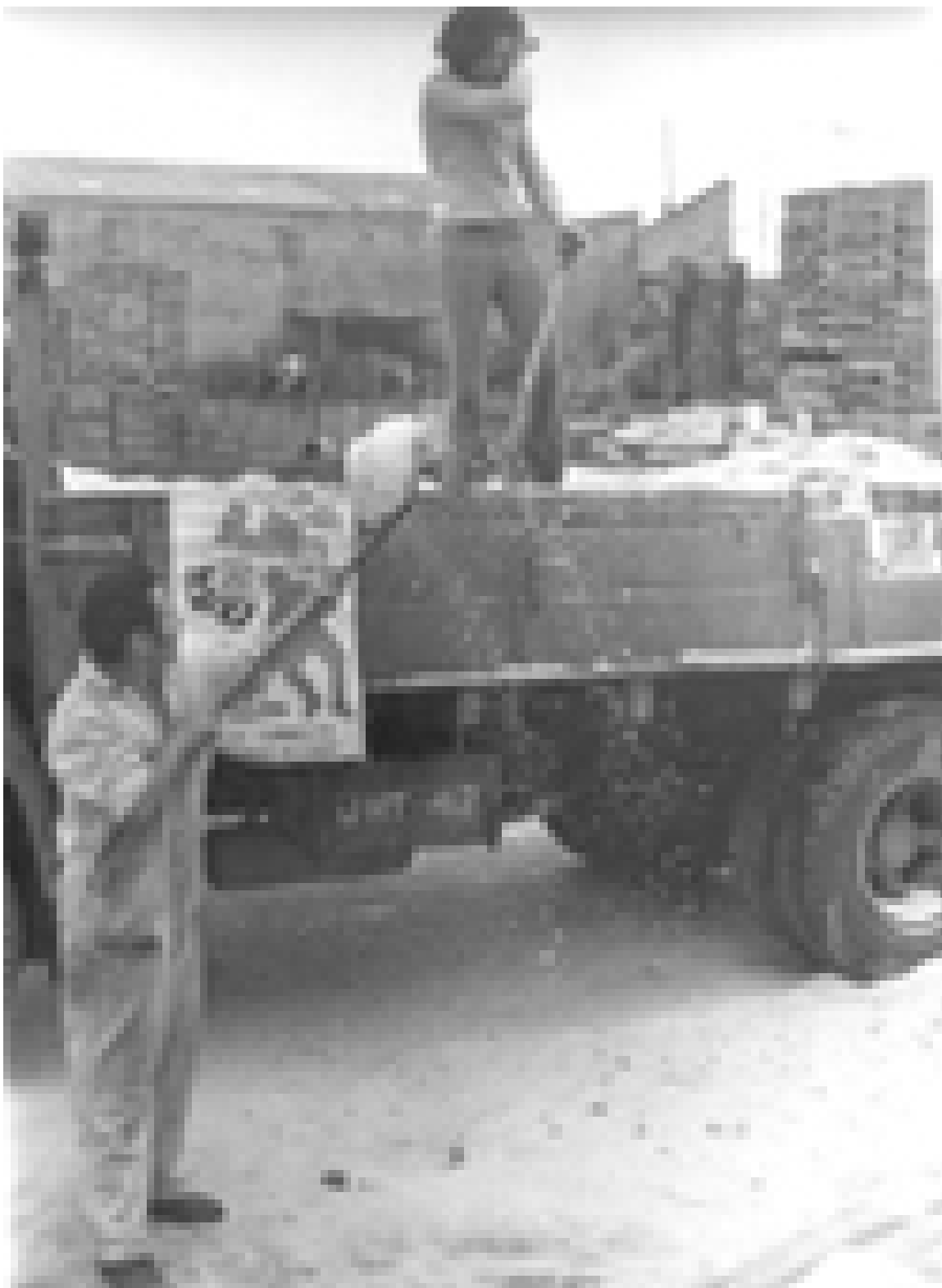
Chile, trabajos voluntarios
