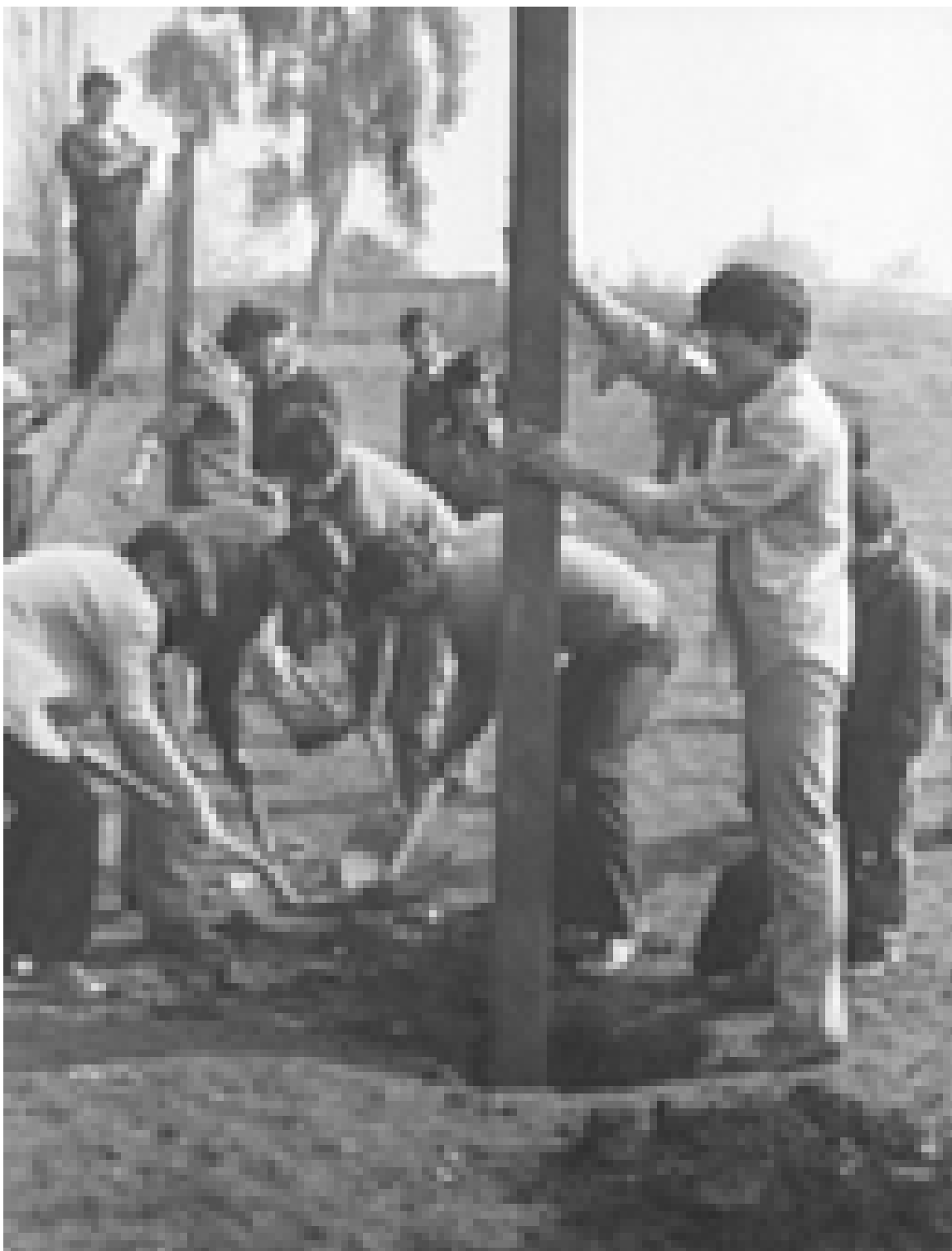
Construcción cancha de fútbol en Población Cipriano Pontigo
