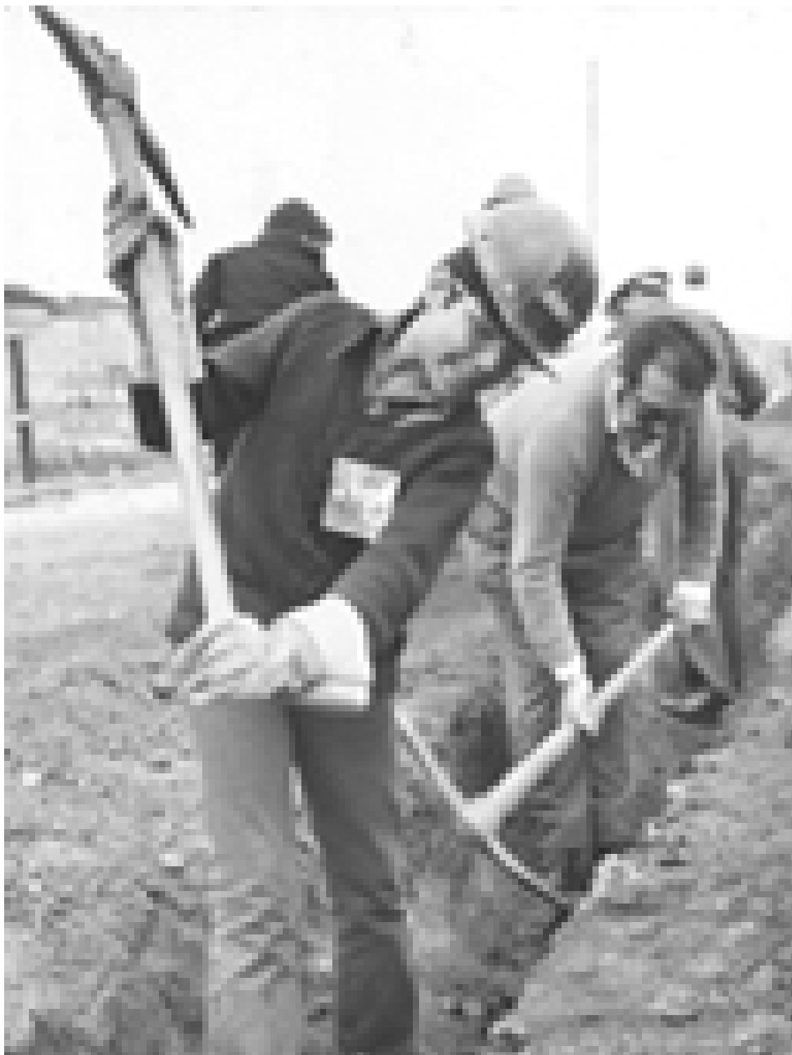
Chile, Trabajos Voluntarios, 1972
