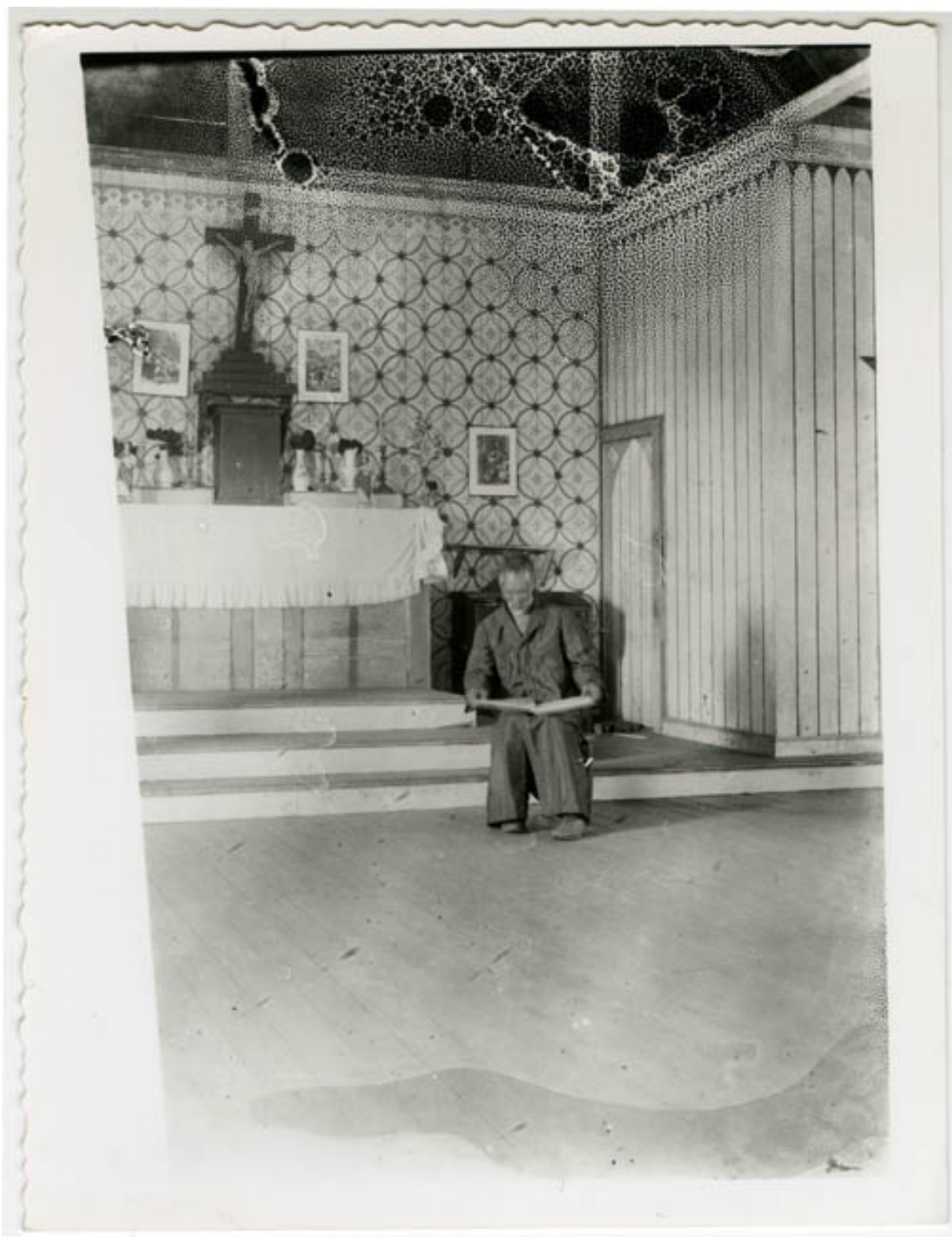
SACERDOTE EN INTERIOR DE LA IGLESIA
