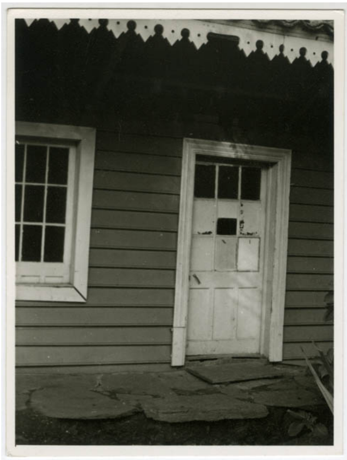
VENTANA Y PUERTA,HUALPEN, CONCEPCION
