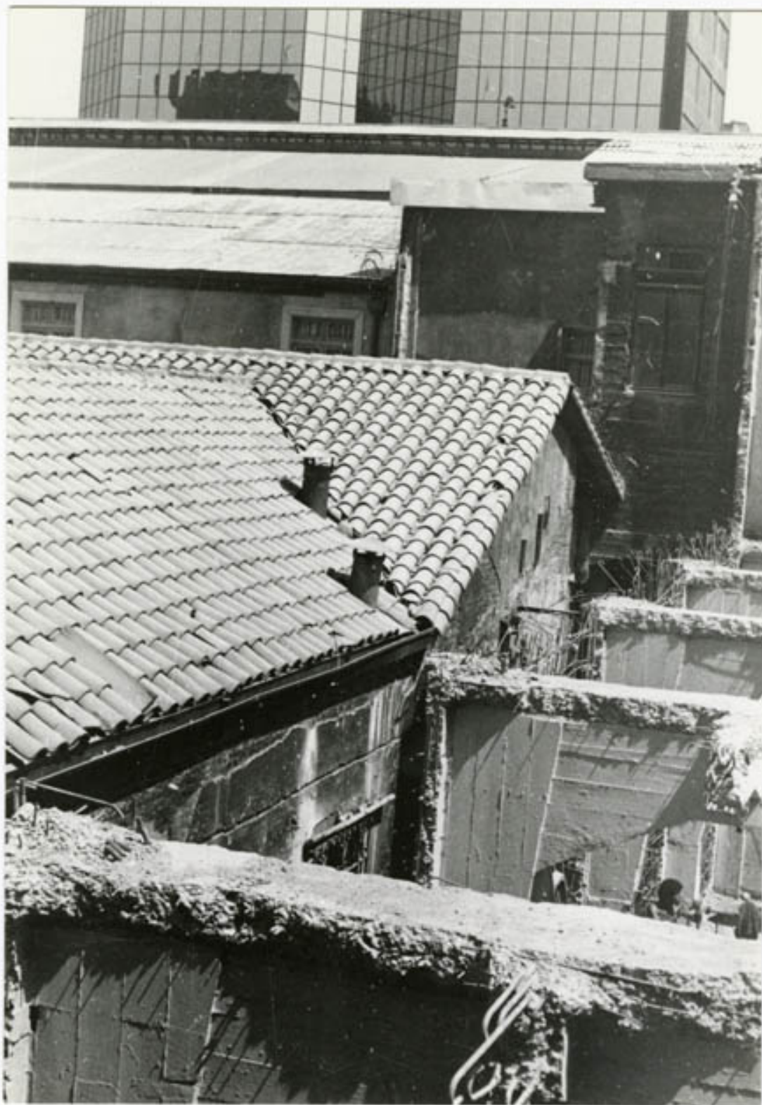
M.H.N.DEMOLICION EX CORREO
