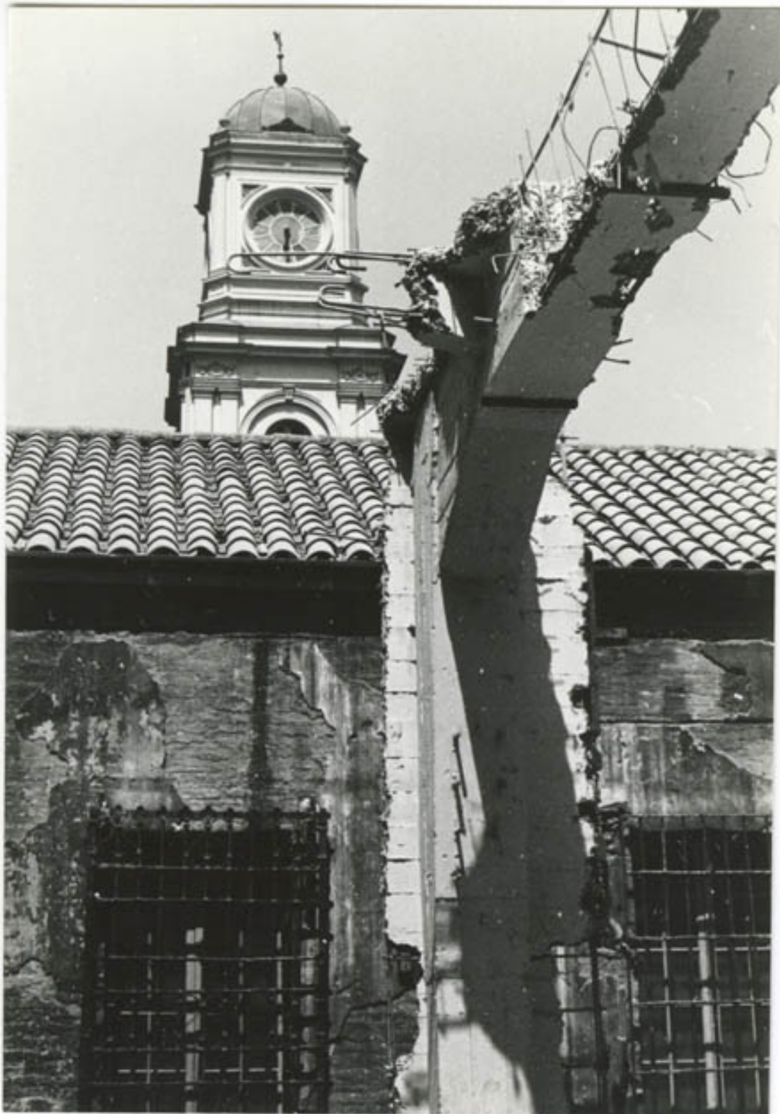
M.H.N.DEMOLICION EX CORREO
