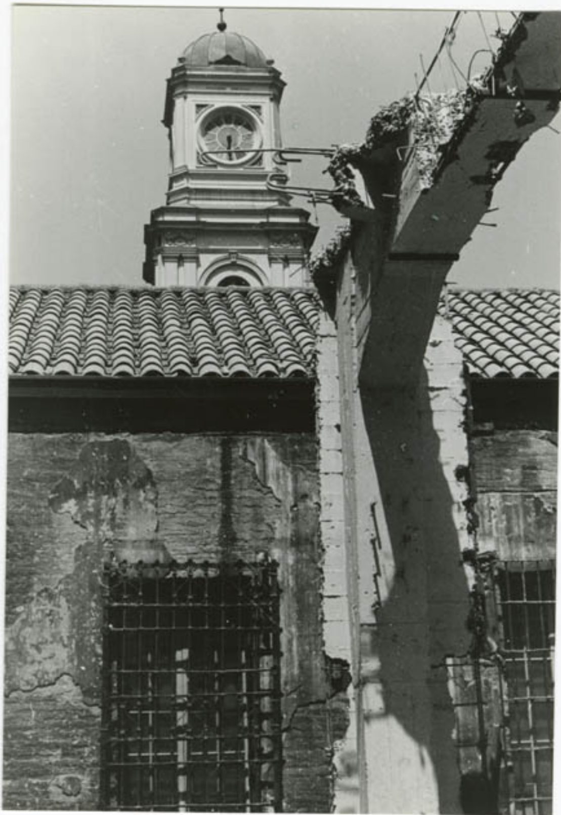
M.H.N.DEMOLICION EX CORREO
