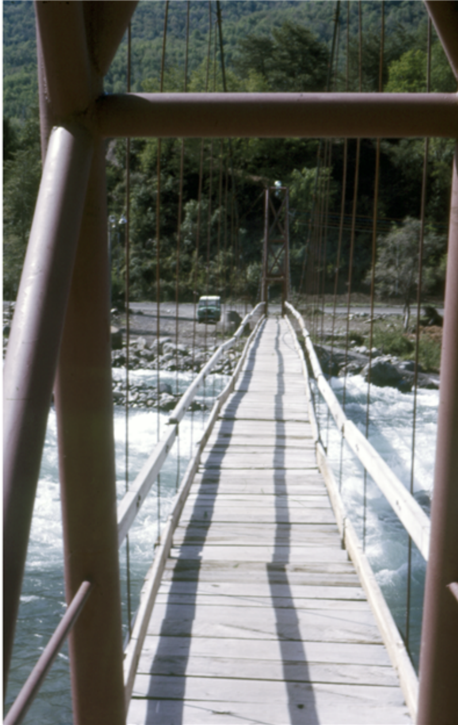
Puente en Central El Toro.
