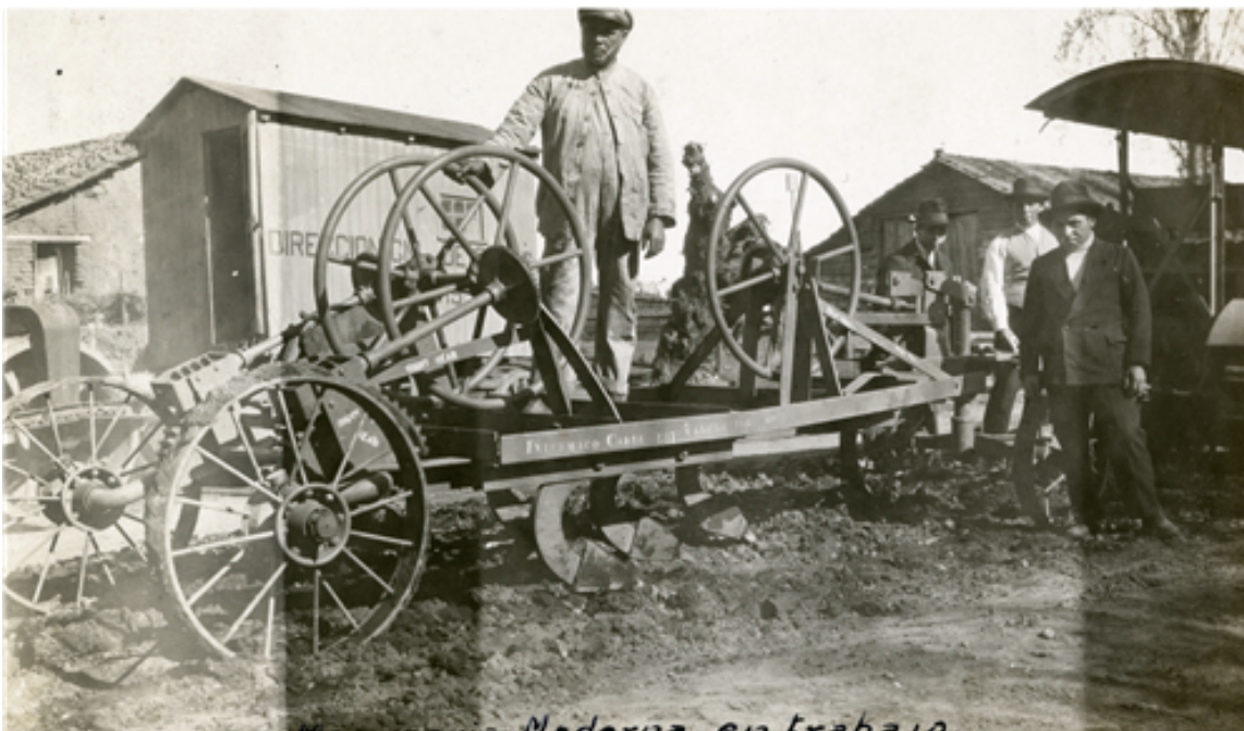
Maquinaria moderna en trabajo
