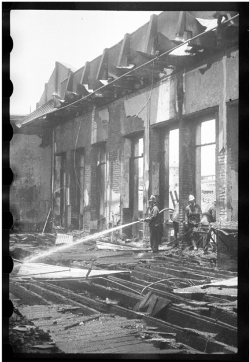
Incendio en la Escuela de Medicina.
