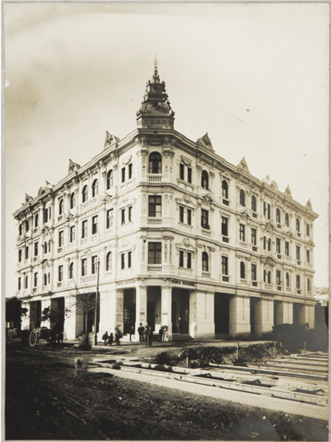
Edificio del Banco Nacional
