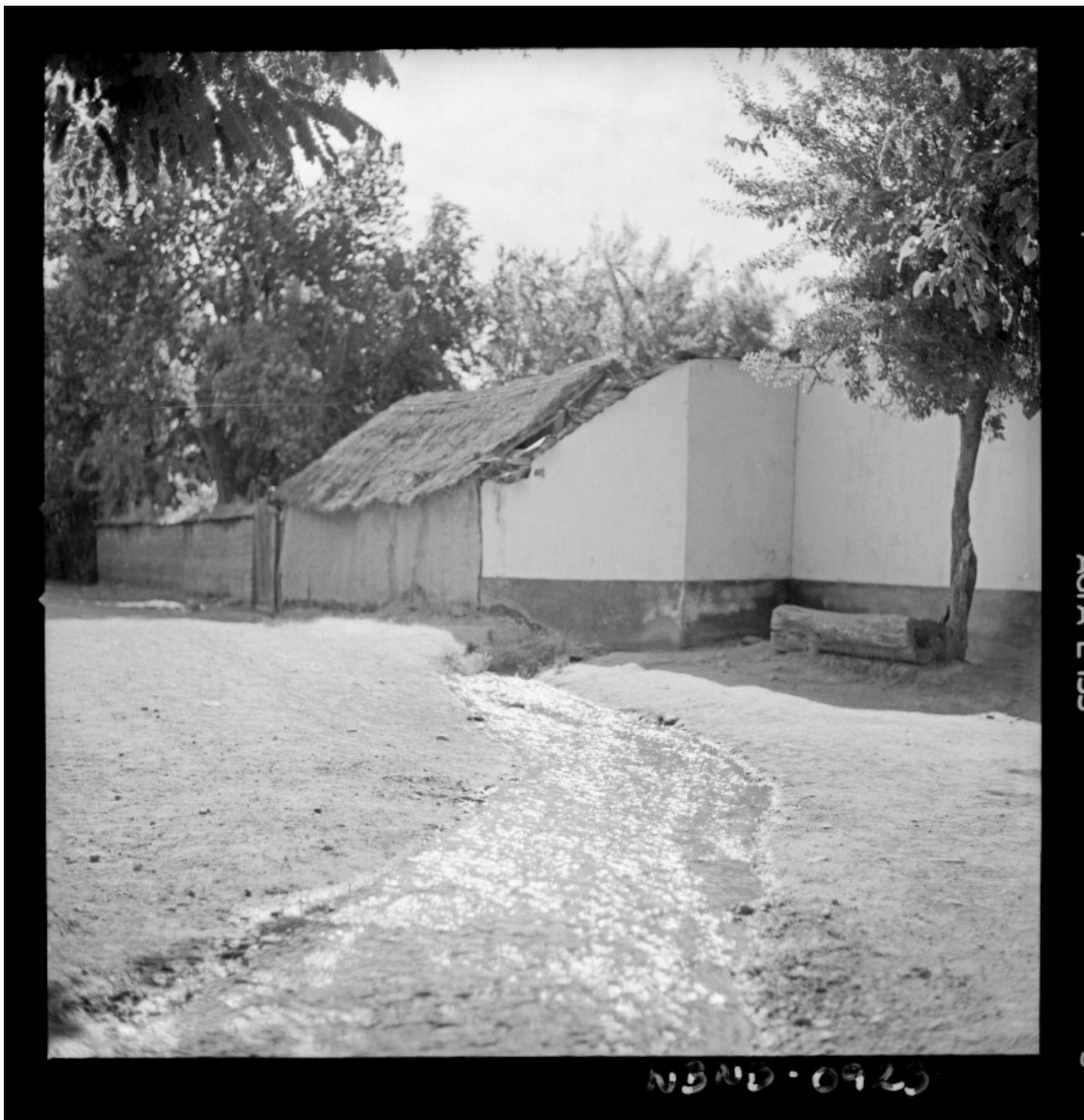
[Vista de pared exterior de casa] [fotografía] Antonio Quintana.
