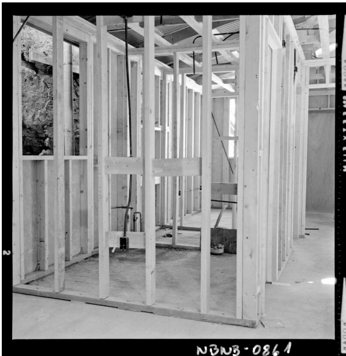
[Estructura de madera] [fotografía] Antonio Quintana.
