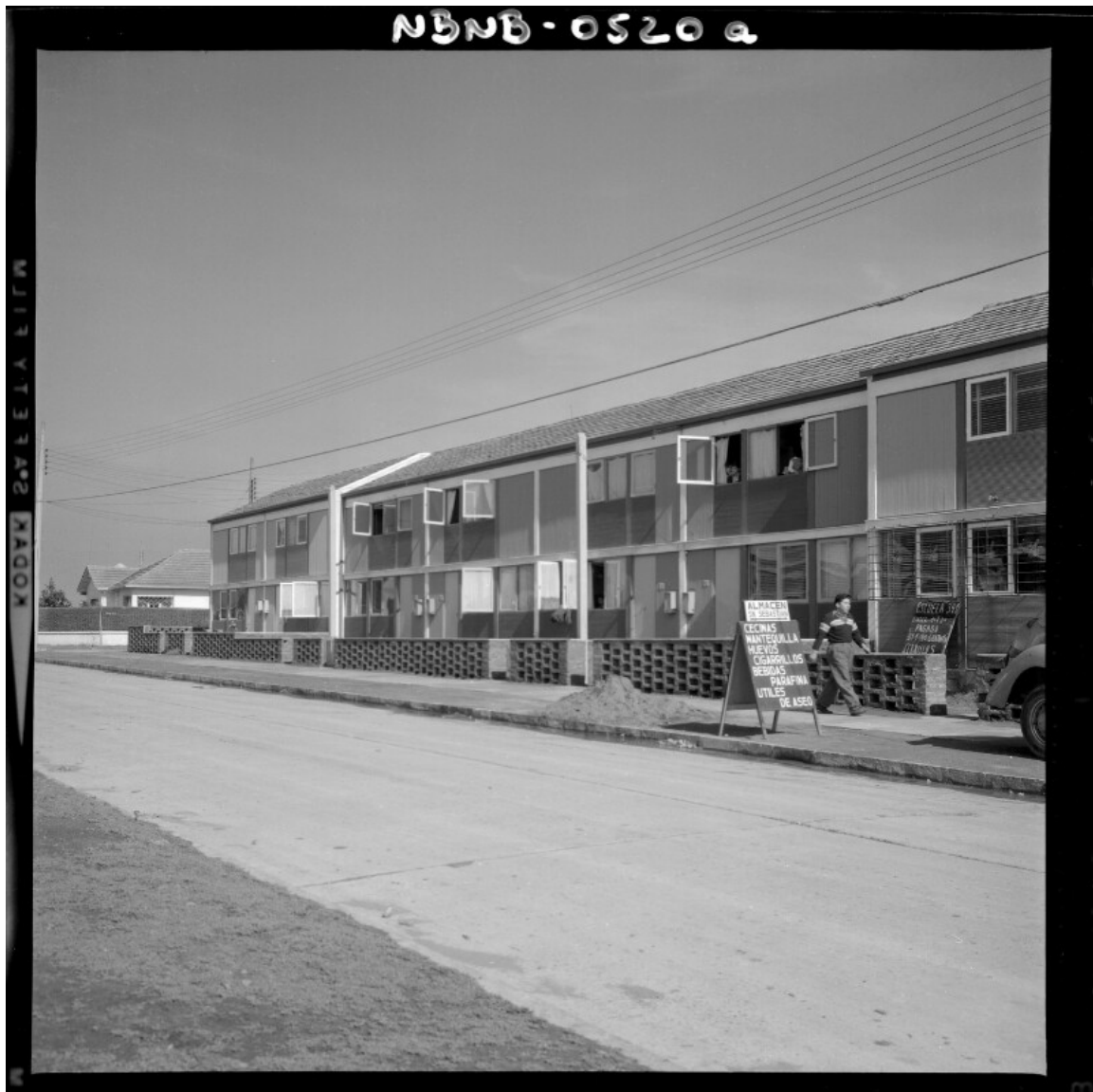
[Conjunto habitacional de casas pareadas] [fotografía] Antonio Quintana.
