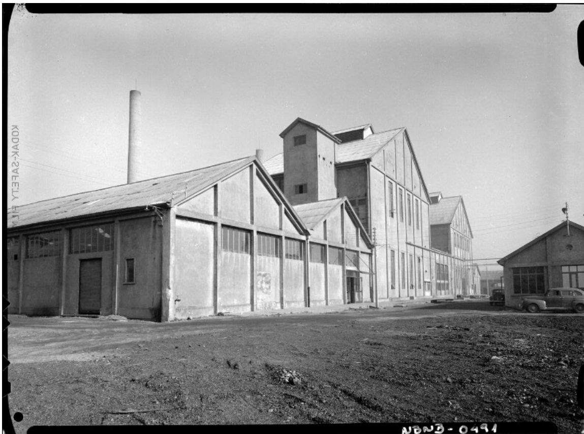
[Vista exterior de fábrica] [fotografía] Antonio Quintana.
