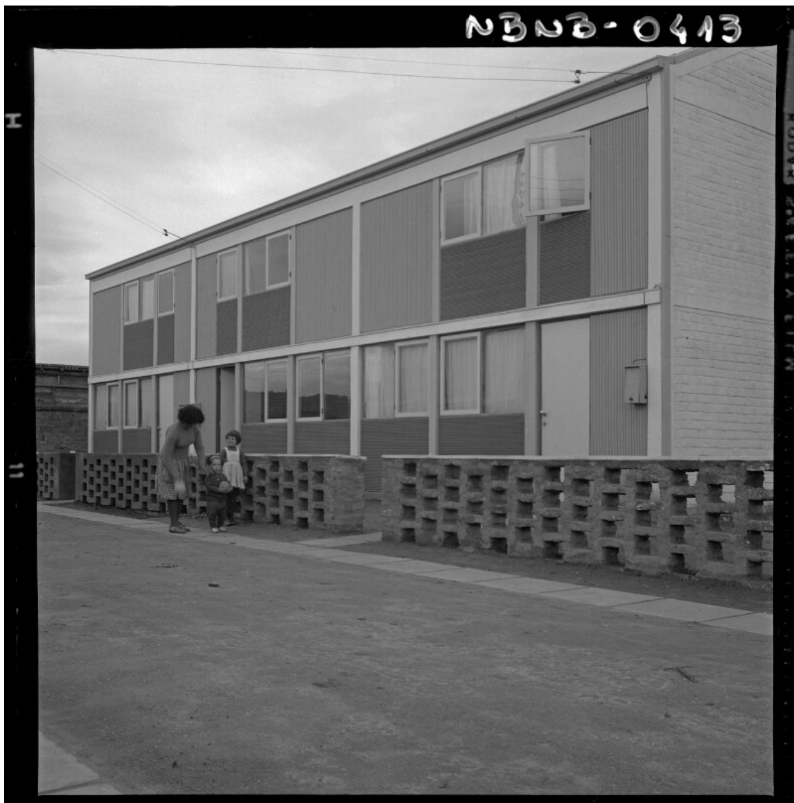
[Conjunto de viviendas] [fotografía] Antonio Quintana.
