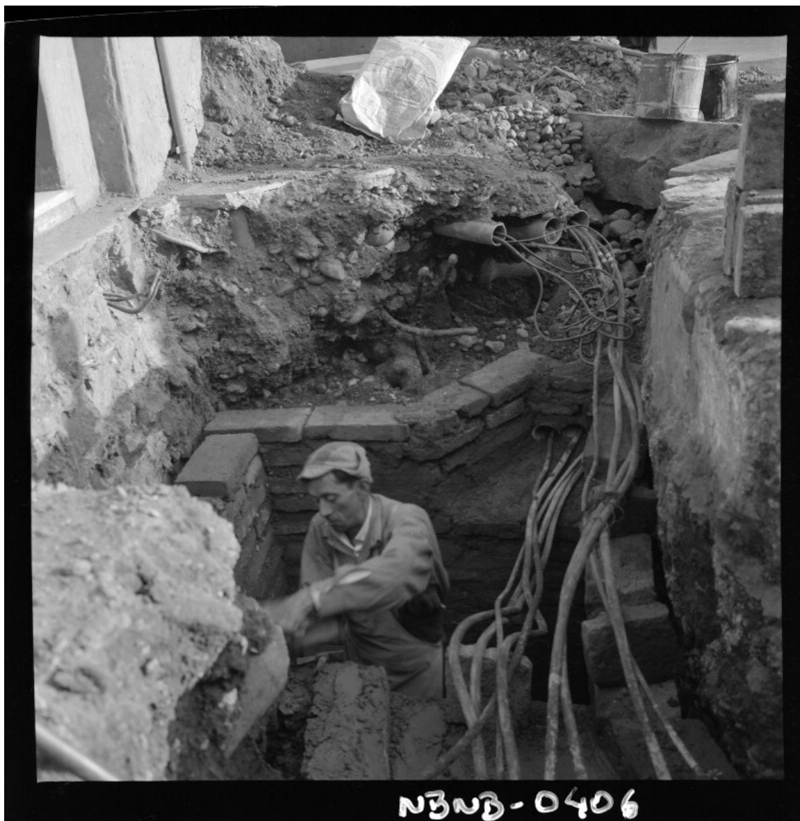
[Construcción de viviendas] [fotografía] Antonio Quintana.
