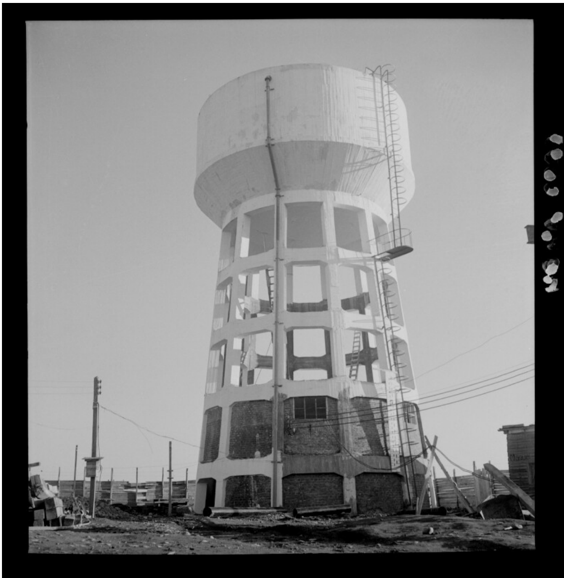
[Tanque elevado de agua] [fotografía] Antonio Quintana.
