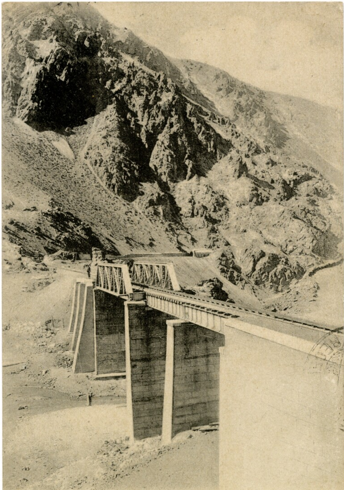
Puente llagando al Portillo. Ferro-carril. Trasandino.
