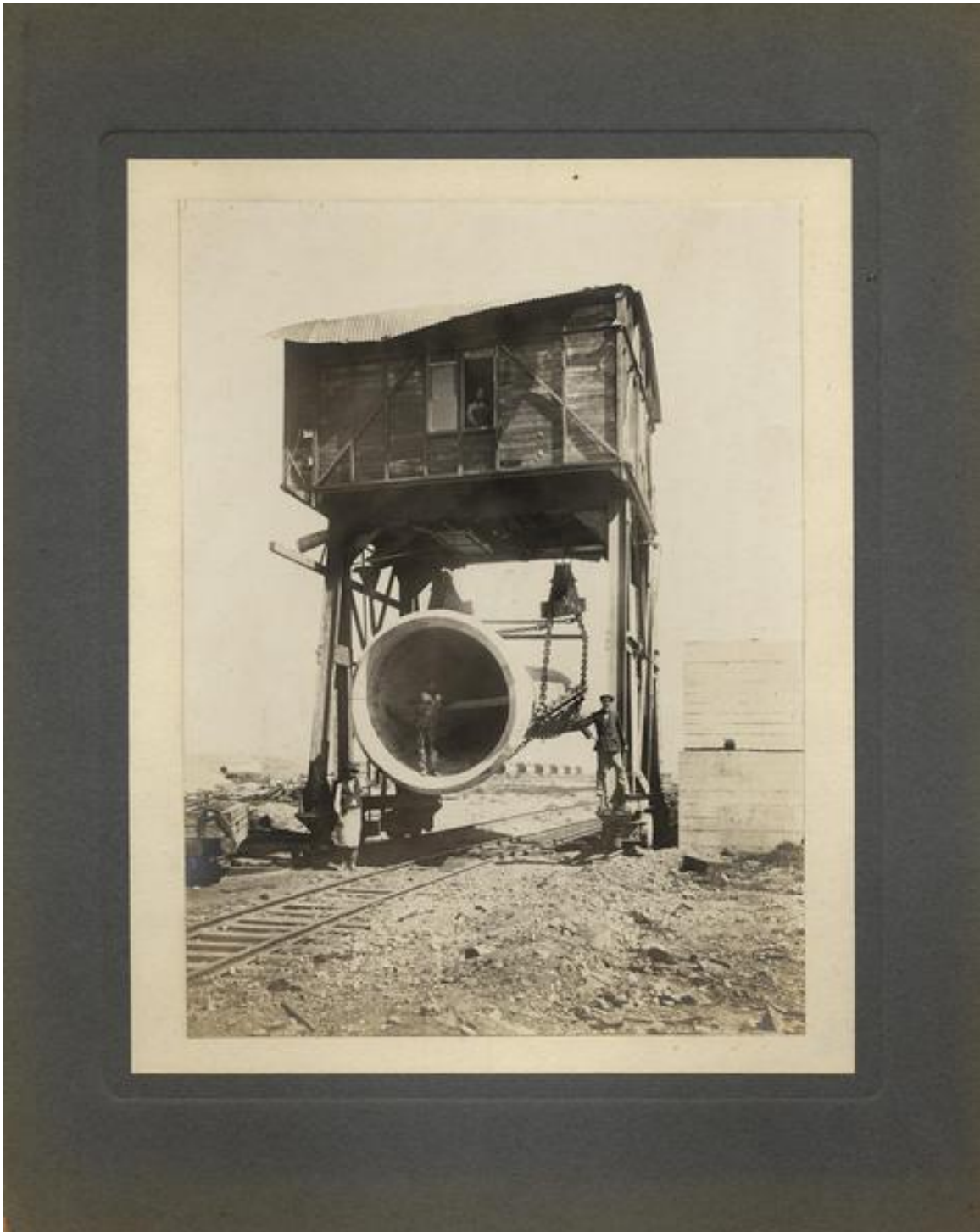
[Trabajadores junto a una estructura hidráulica, antes de su instalación] [fotografía].
