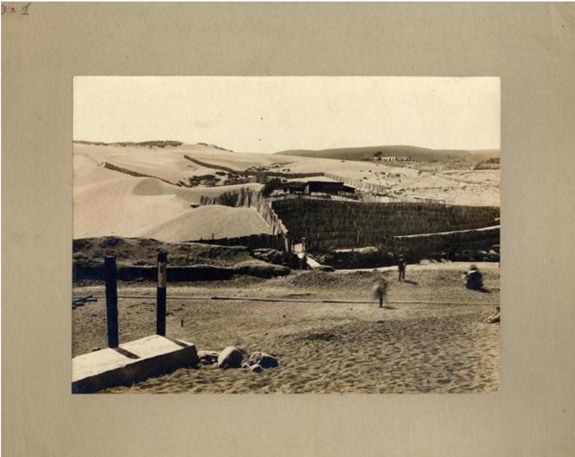
[Vista parcial de una construcción cerca de Dunas] [fotografía].
