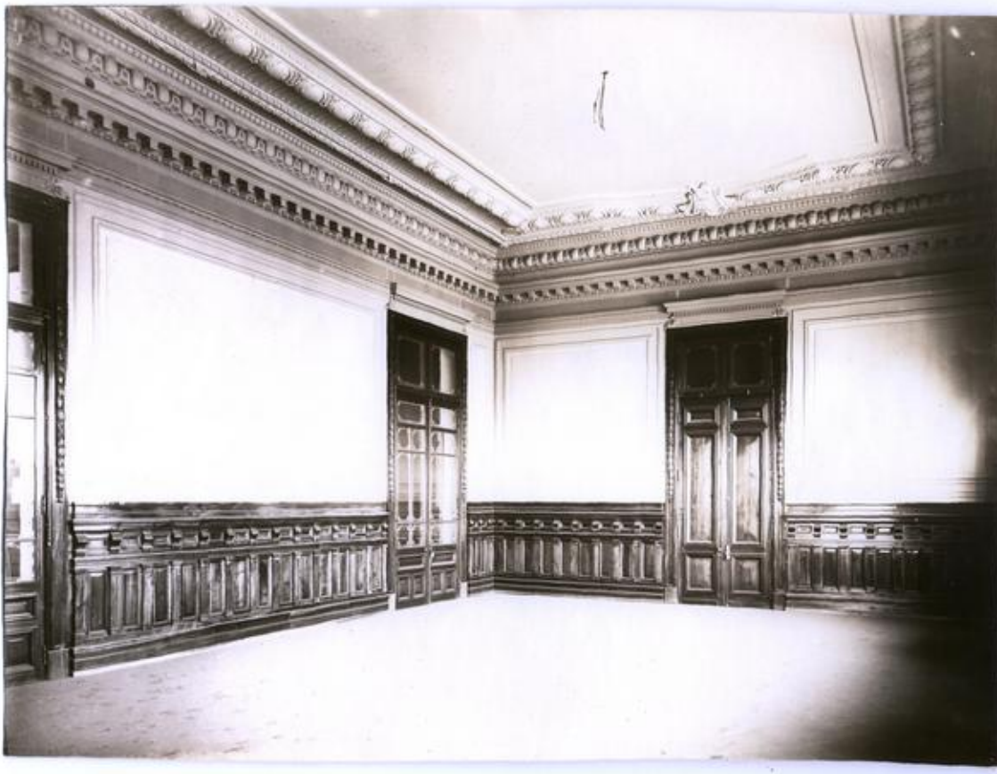
[Biblioteca Nacional 1923. Salones interiores, primer piso] [fotografía].
