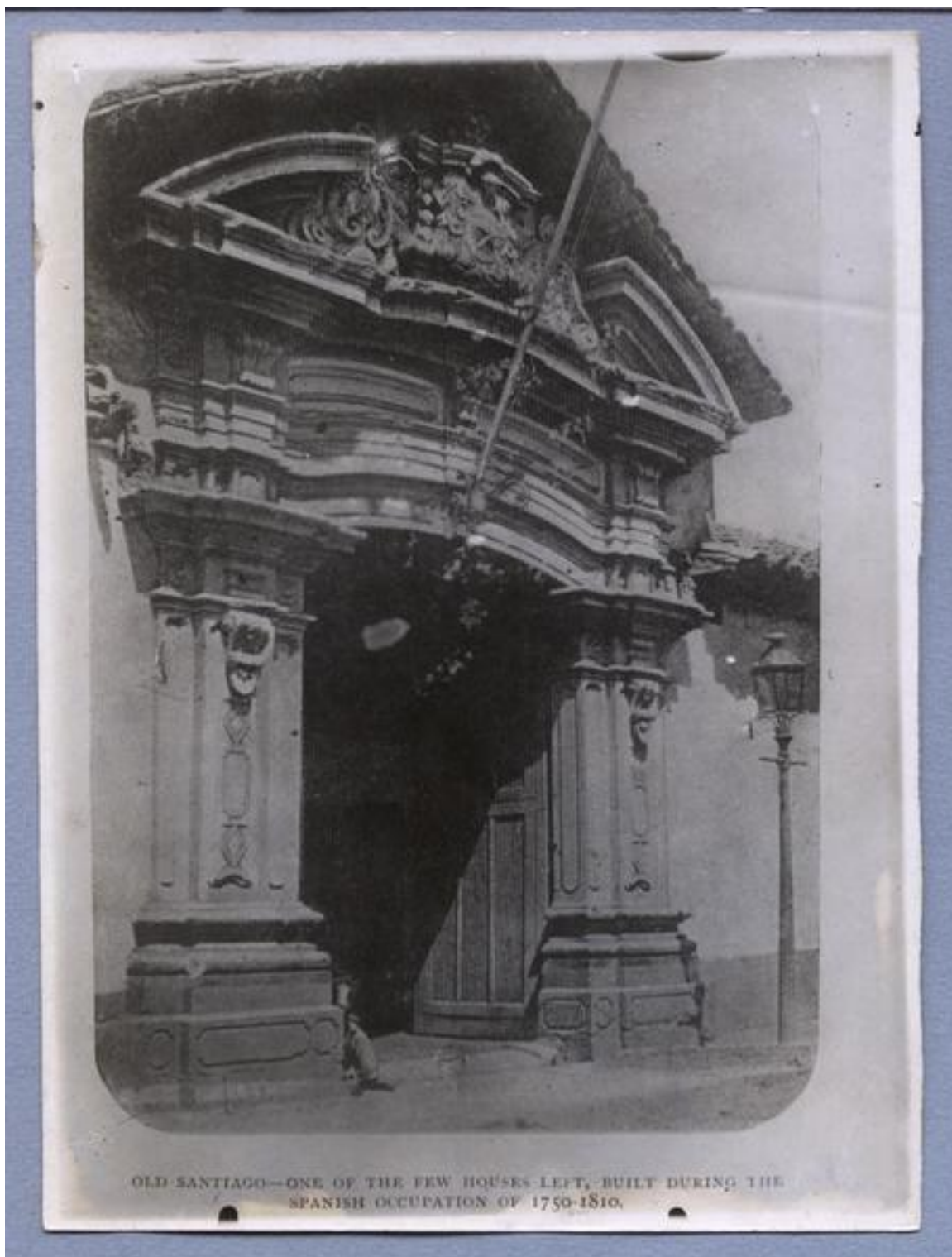
[Fachada de una casa construida en el antiguo Santiago, durante la ocupación española 1750-1810] [fotografía].
