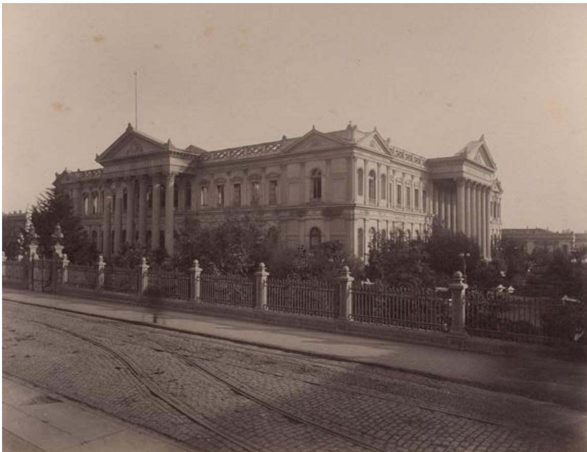
[Edificio: Congreso Nacional de Chile, Santiago] [fotografía].
