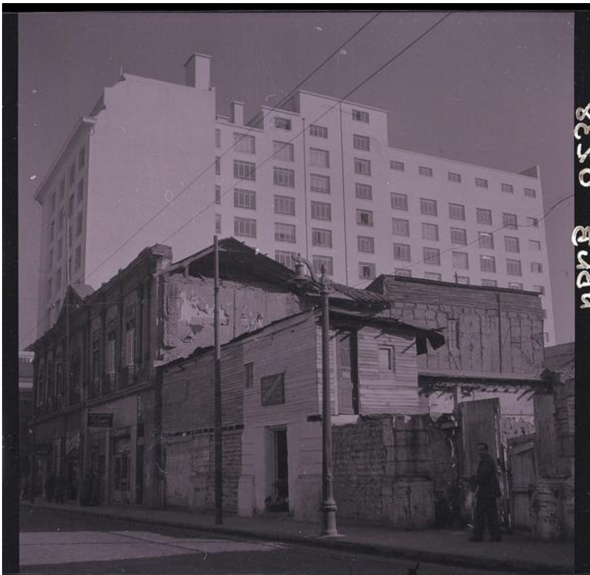
[Transeúntes, casas antiguas en demolición, contiguo a edificio de departamentos] [fotografía]
