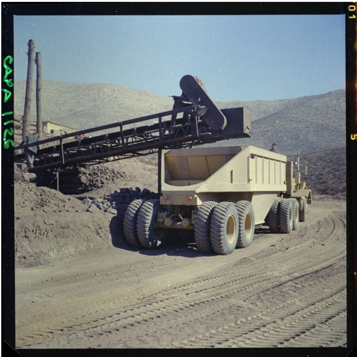
[Obras de construcción, mina "El Algarrobo"] [fotografía] Luis Ladrón de Guevara.
