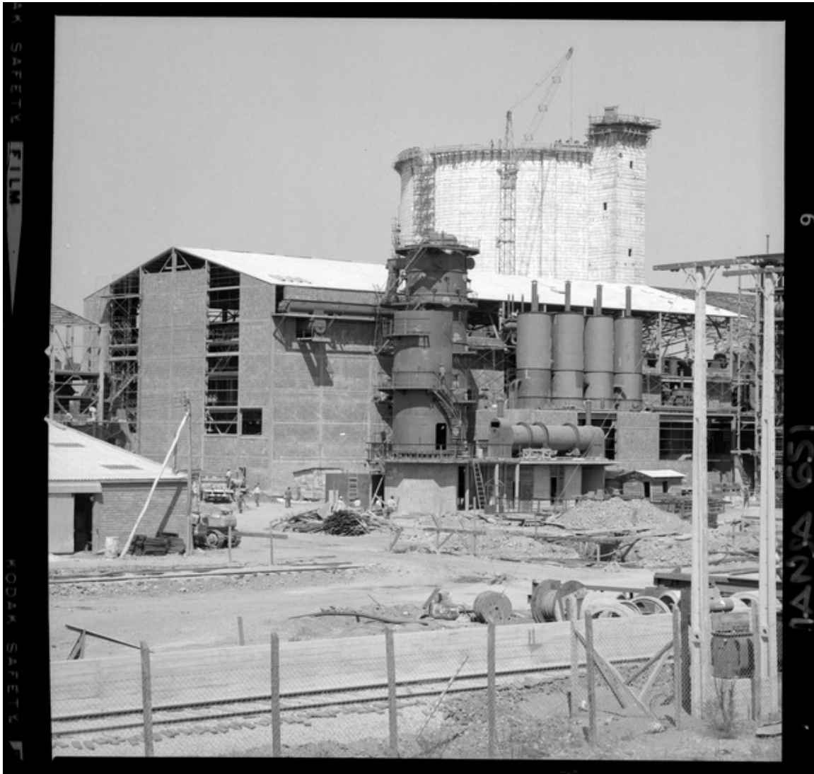
[Iansa (Chile) : Planta Curicó : Obra en construcción] [fotografía] Luis Ladrón de Guevara.
