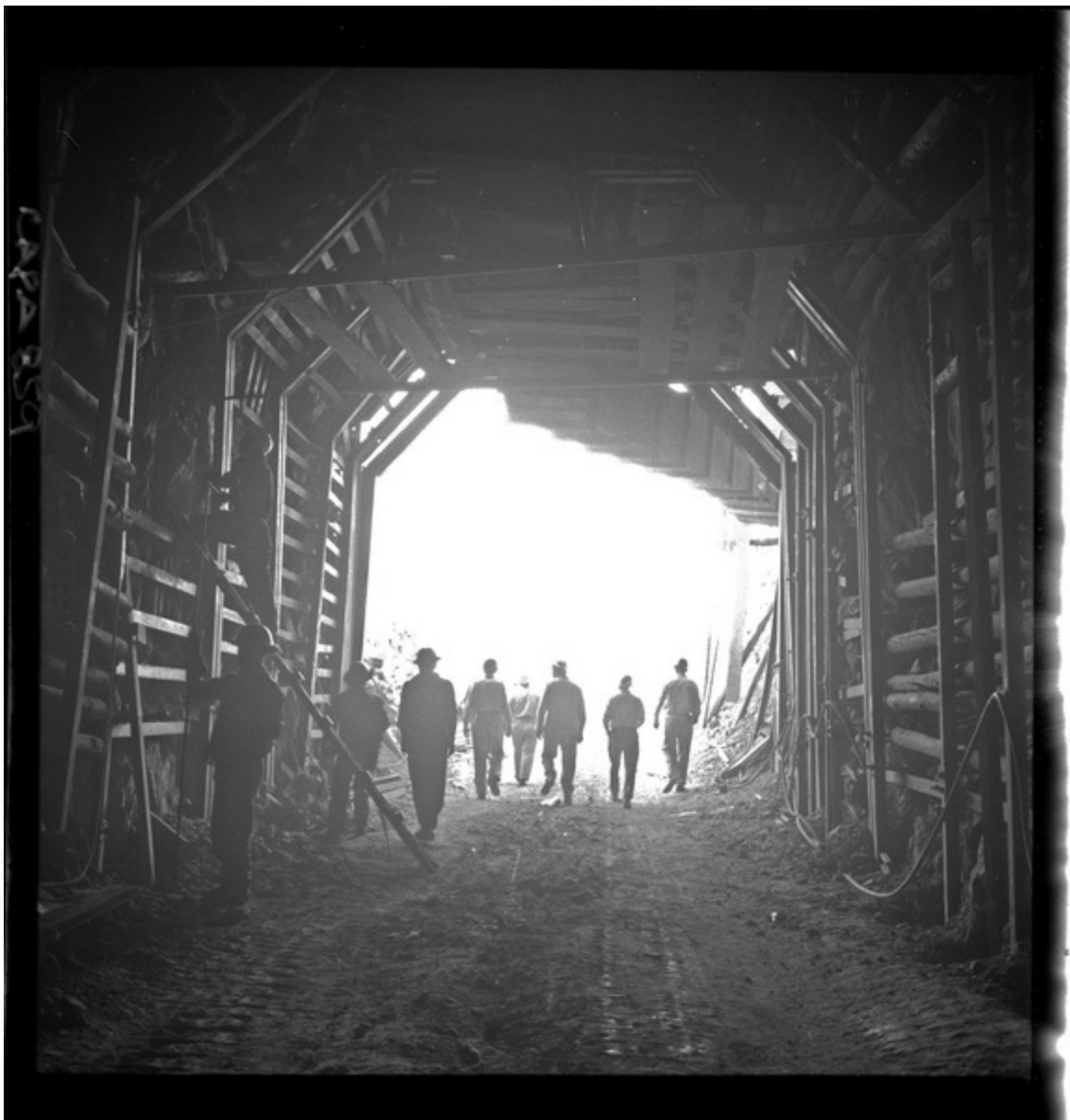
[Mineros salen al exterior, mina "El Algarrobo"] [fotografía] Luis Ladrón de Guevara.
