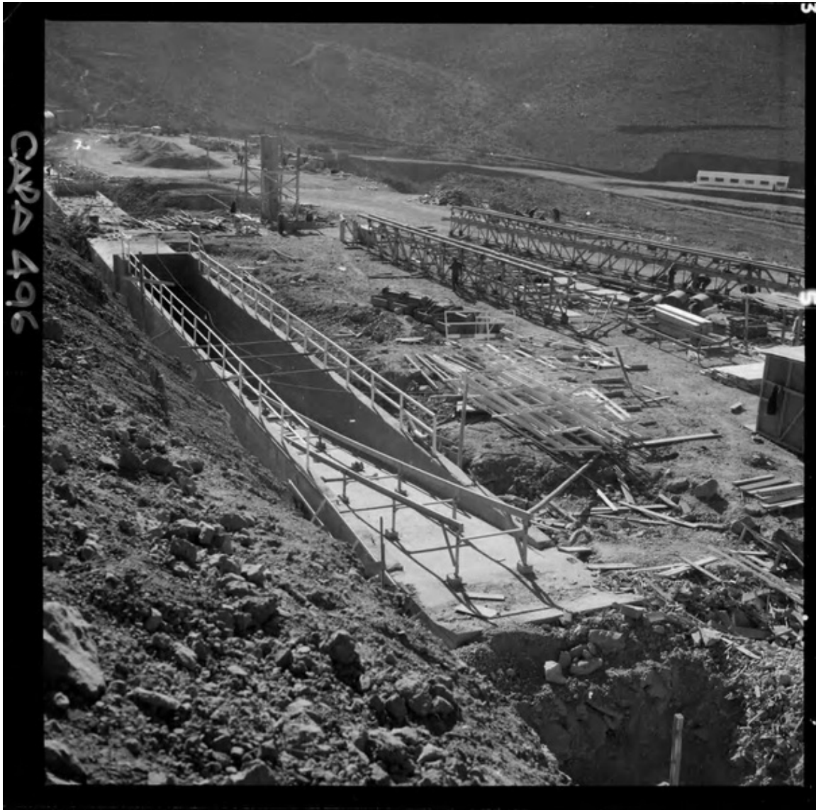
[Obras de construccion, mina "El Algarrobo"] [fotografía] Luis Ladrón de Guevara.
