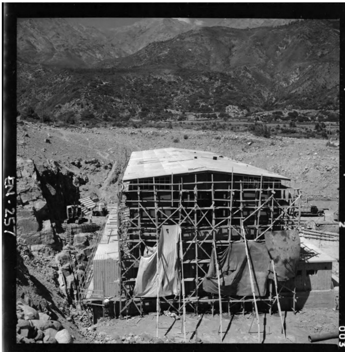
[Construcción de la casa de máquinas] [fotografía] Luis Ladrón de Guevara.
