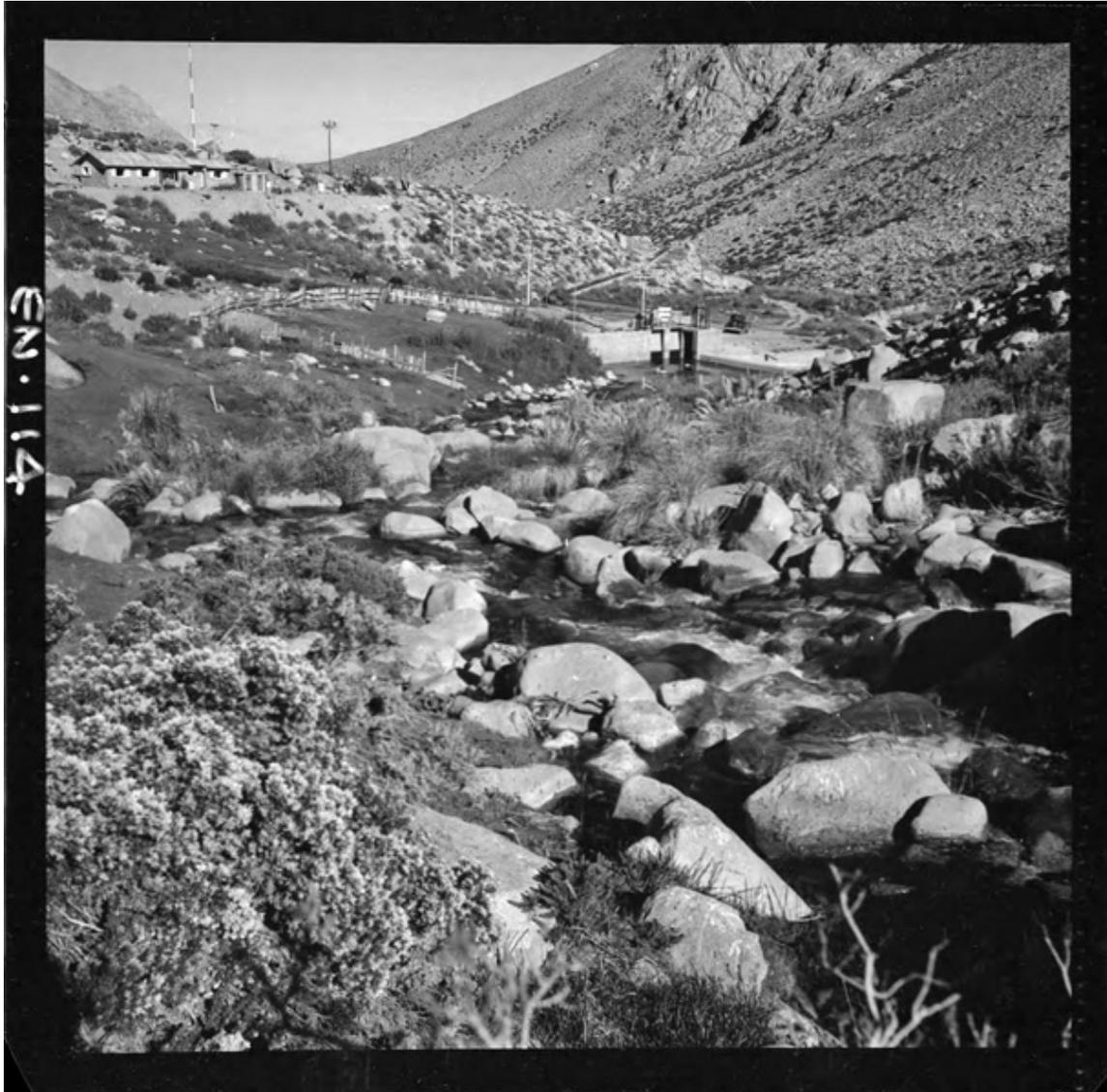
**Bocatoma ubicada a 2600 m. sobre el nivel del mar : capta el agua del río Los Molles y mediante dos compuertas la entrega al canal de aducción. Este discurre cubierto por 17 km. hasta la cámara de carga [fotografía] Luis Ladrón de Guevara.**
