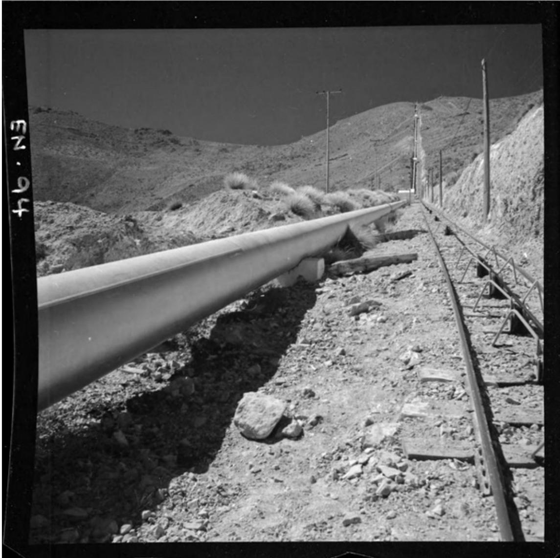
**[Funicular para montaje y mantenimiento junto a la tubería de presión. Es uno de los más largos y de gran desnivel construido en el mundo] [fotografía] Luis Ladrón de Guevara.**
