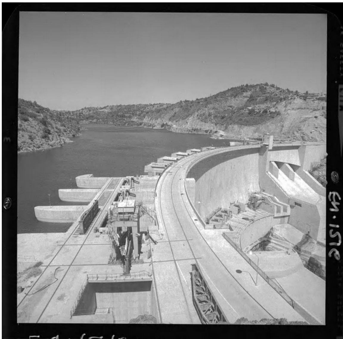
[Central Hidroeléctrica "Los Molles"] [fotografía] Luis Ladrón de Guevara.
