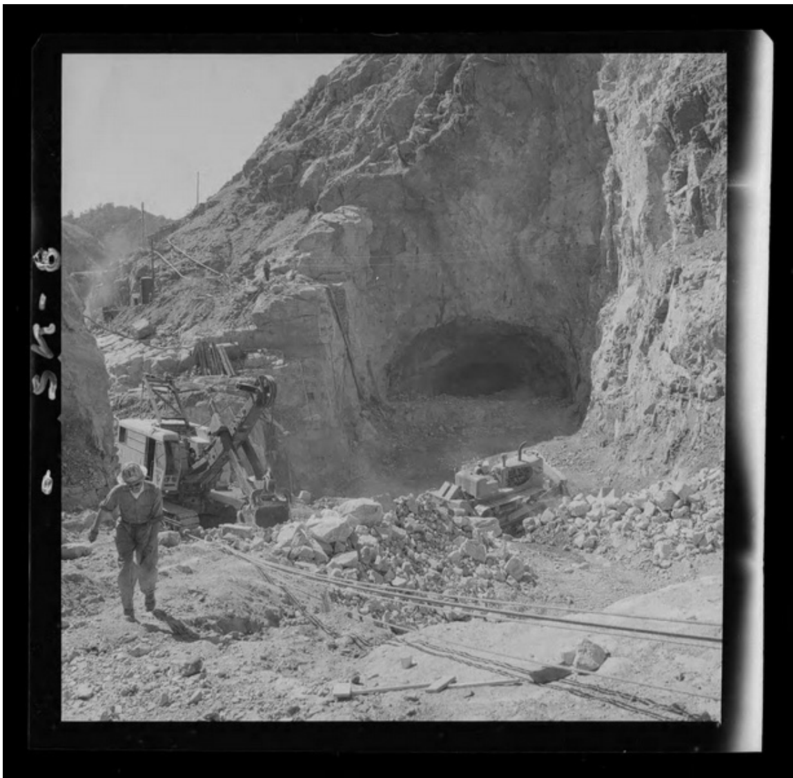
[Construcción entrada del túnel común de aducción] [fotografía] Luis Ladrón de Guevara.
