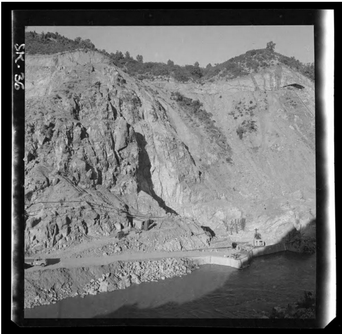
[Construcción entrada del túnel común de aducción] [fotografía] Luis Ladrón de Guevara.
