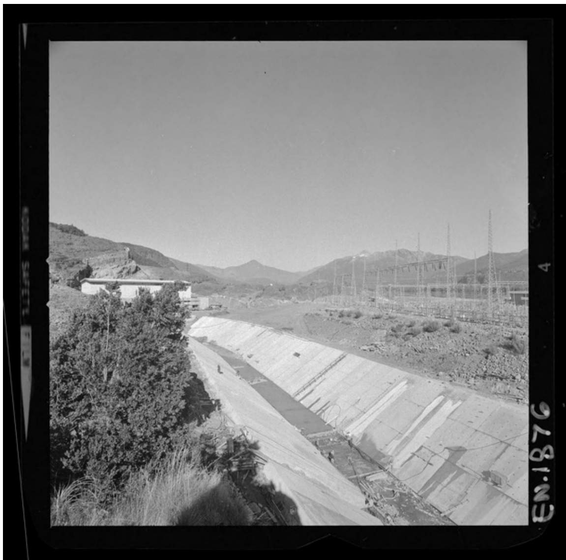
[Casa de máquinas en una segunda etapa : Construcción del canal de evacuación] [fotografía] Luis Ladrón de Guevara.
