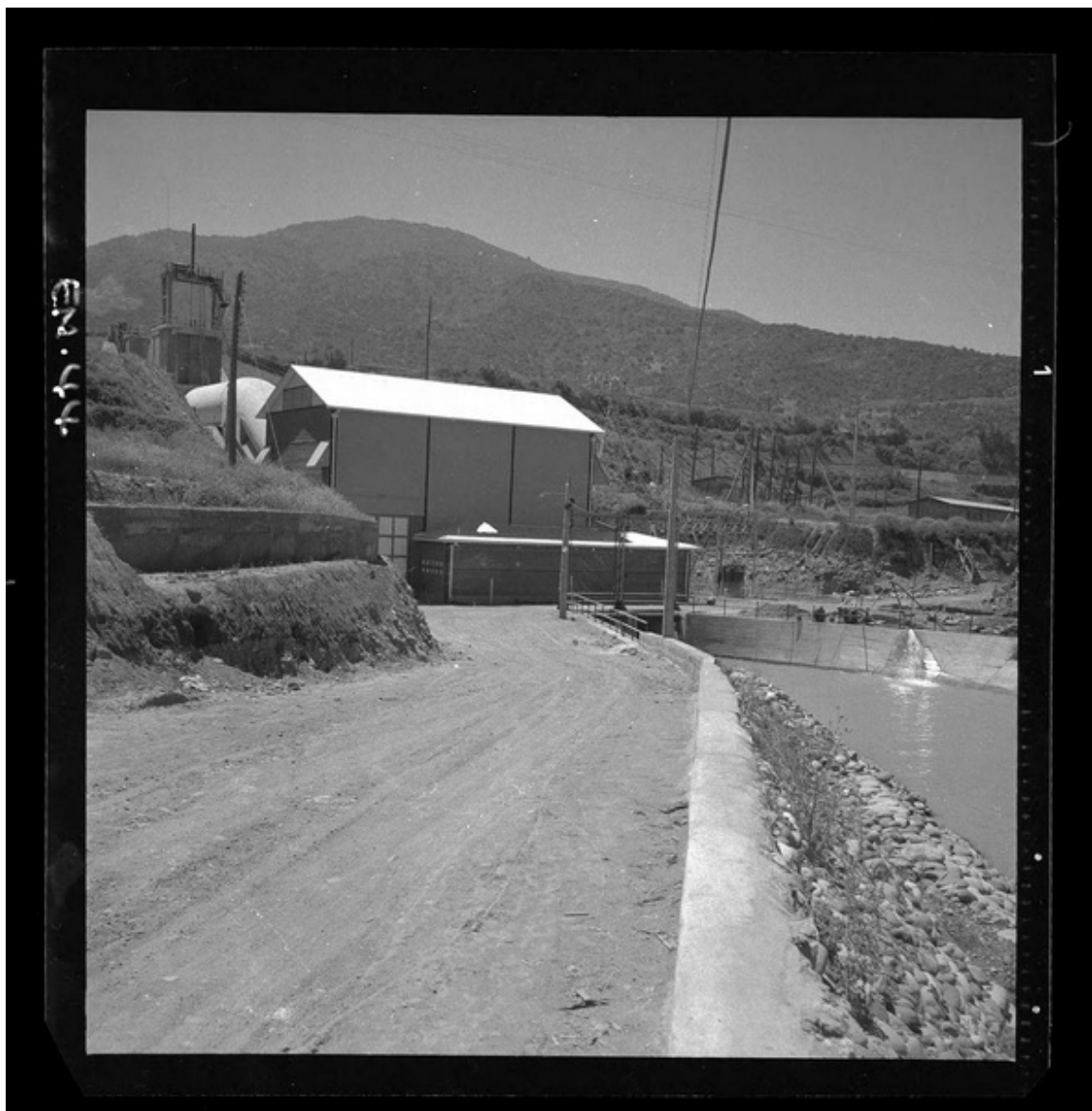
[Central Hidroeléctrica "Sauzalito"] [fotografía] Luis Ladrón de Guevara.
