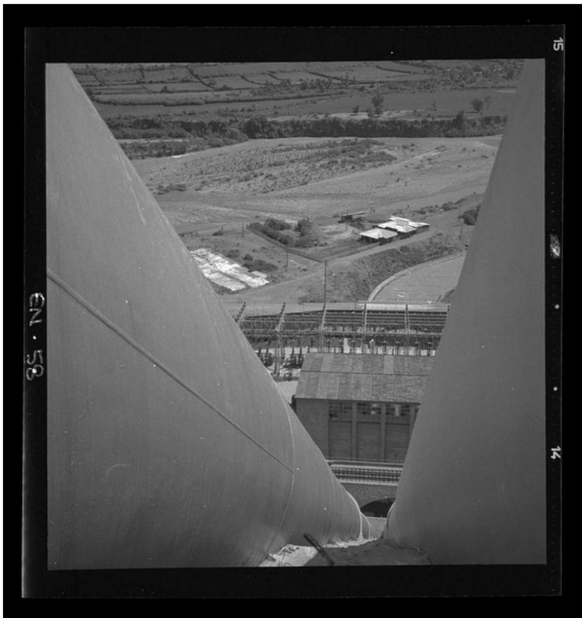
**[Vista parcial, de cañerías metálicas, conducen el agua de la cámara de carga a la casa de máquinas, descenso casi vertical de 120 m.] [fotografía] Luis Ladrón de Guevara.**
