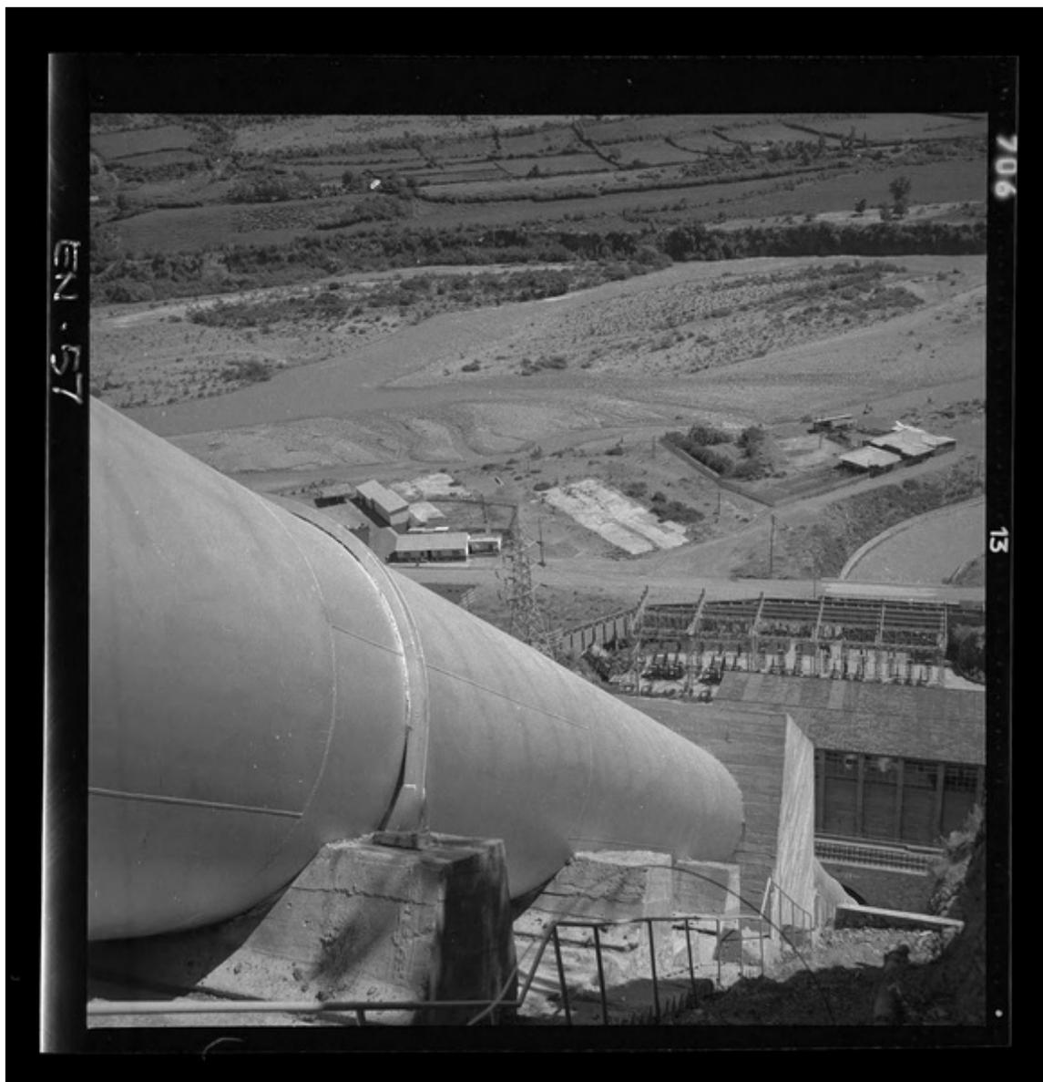
**[Vista de cañerías metálicas, conducen el agua de la cámara de carga a la casa de máquinas, descenso casi vertical de 120 m.]
