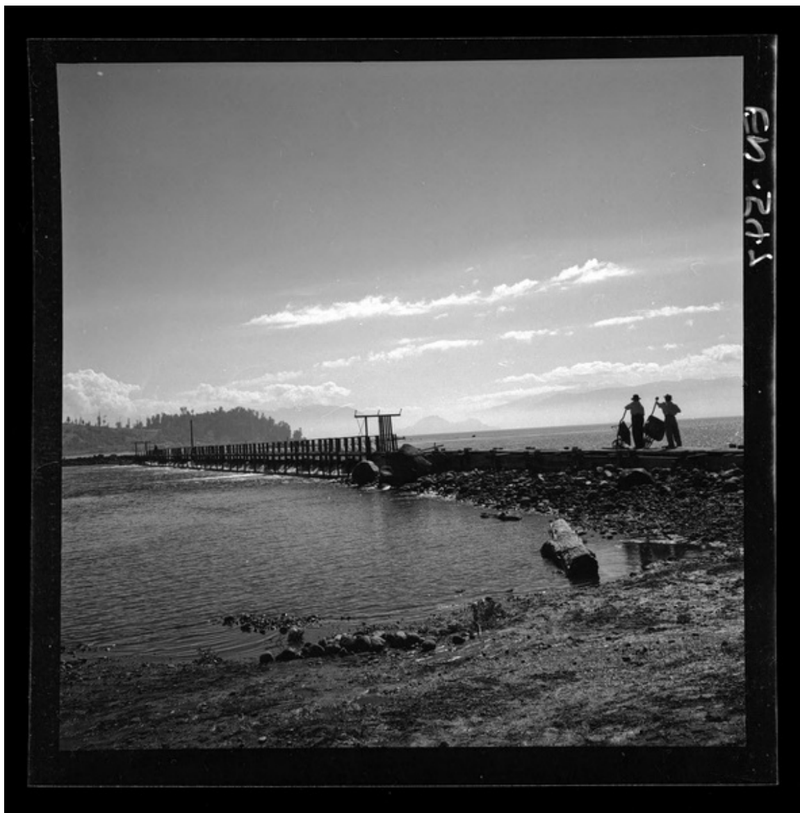
[Trabajadores; Central "Pilmaiquén", Bocatoma del río Pilmaiquén] [fotografía] Luis Ladrón de Guevara.
