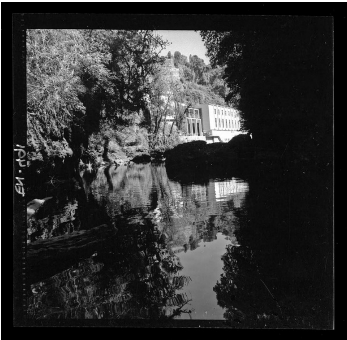
[Vista de la Central "Pilmaiquén" y su entorno] [fotografía] Luis Ladrón de Guevara.
