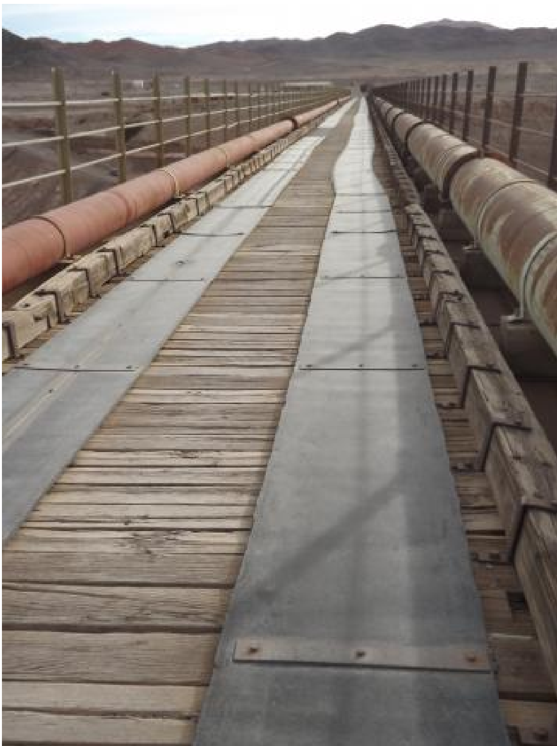
Viaducto de Conchi sobre el río Loa
